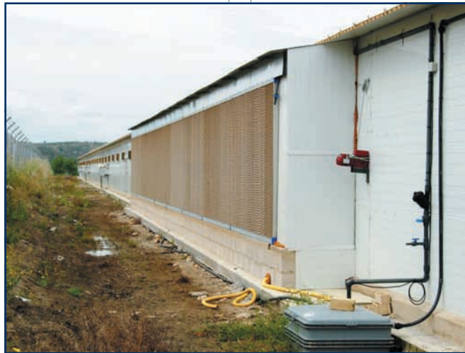
Nave oscura en construcción; puede apreciarse el panel de refrigeración evaporativa, la valla perimetral y el sistema de trampillas; las paredes y la cumbre, son de sándwich de chapa y poliuretano.
