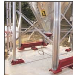
Silos con células de carga
