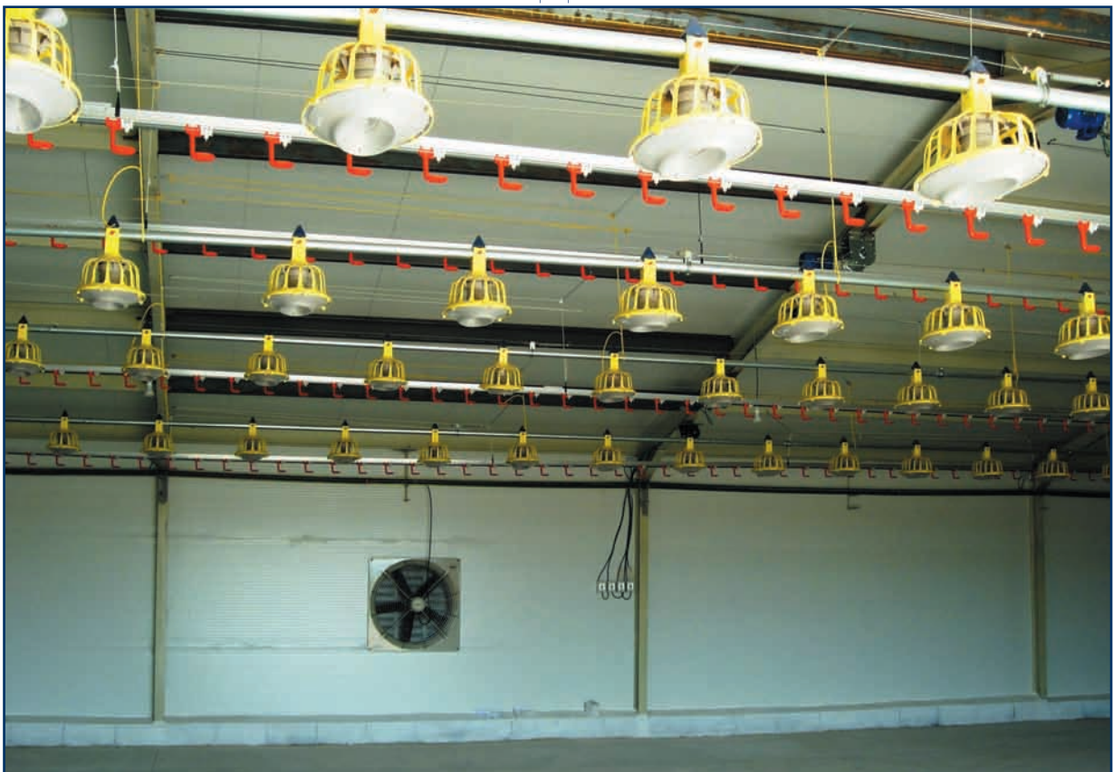
Granja oscura con ventilación de mínimos recién montada donde se puede apreciar la distribución de las líneas de comederos y de tetinas. Las paredes y la cubierta están construidas con sándwich de chapa y poliuretano.
